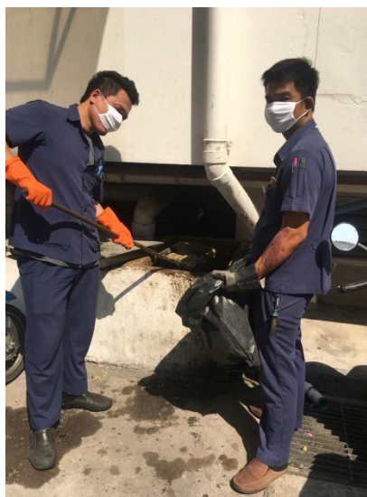
ภาพที่ 1-8 บ่อดักไขมัน และการดักไขมันของเจ้าหน้าที่ประจำโครงการฯ
